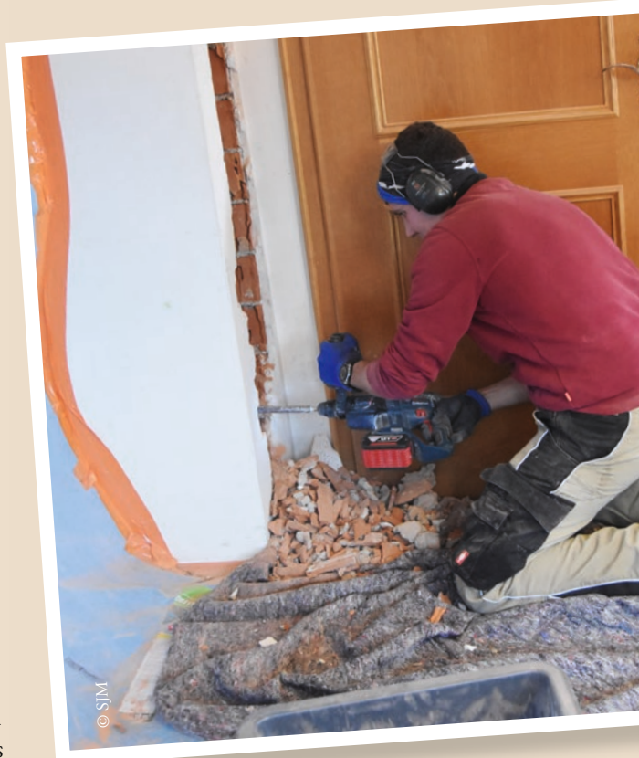
Fr. Rafael legt die alten Rohre frei
